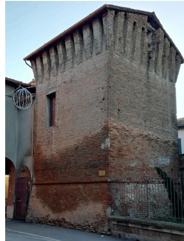
Vista frontale della Torraccia - Foto della proprietà
